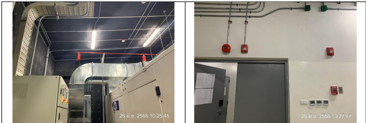
ระบบป้องกันและระงับอัคคีภัยภายในห้องไฟหลัก
